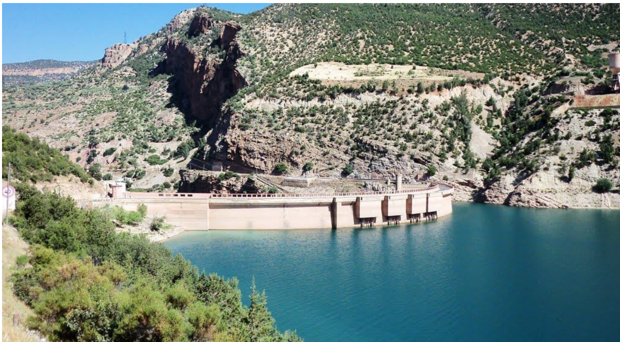
Photo 2 : Barrage Bin El Ouidane - Azilal
